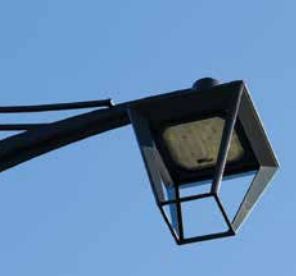
La 1 ère phase du remplacement de l'éclairage est terminée.
