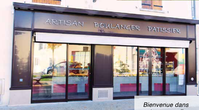
... même pendant les travaux !
