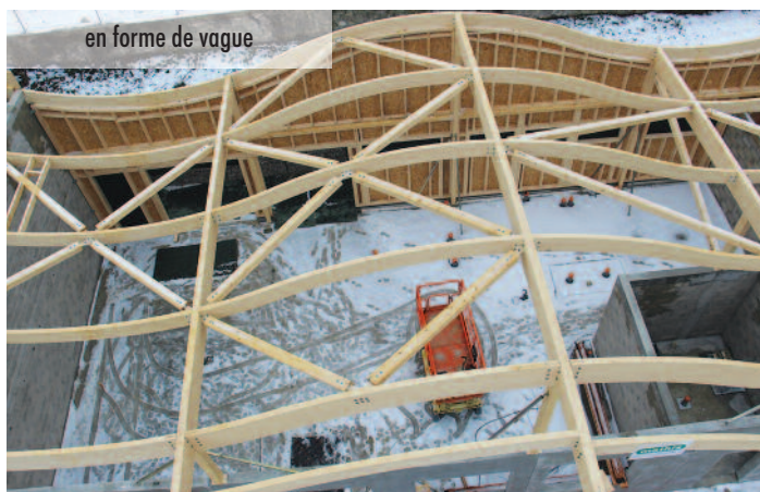
La charpente en bois...
