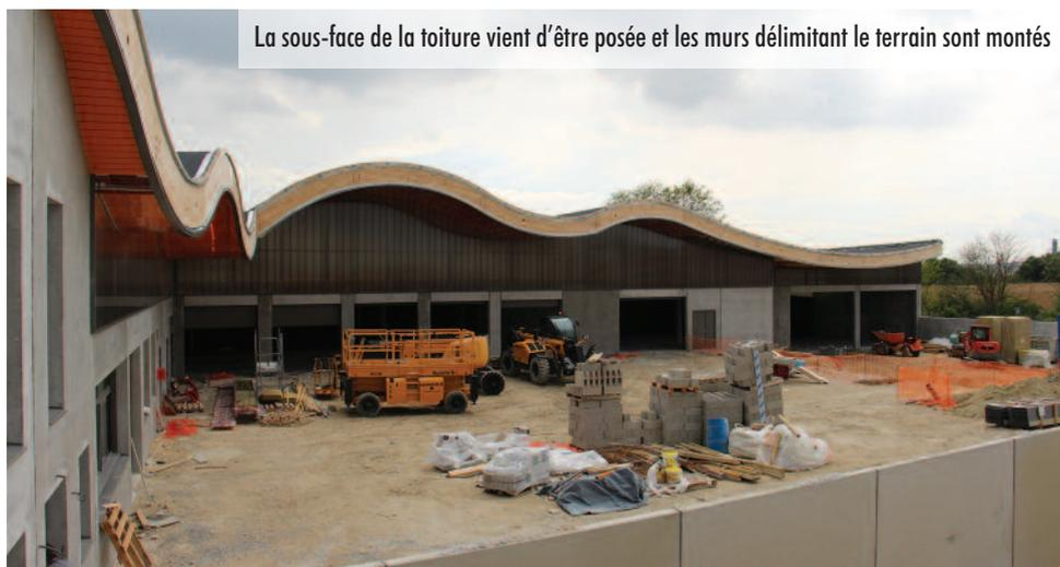
La sous-face de la toiture vient d'être posée et les murs délimitant le terrain sont montés
