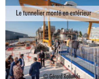
voussoirs, wagons du trains suiveurs...) en surface avant leur descente en 3 morceaux au fond du puits, à l'aide d'un portique", explique la SGP.
