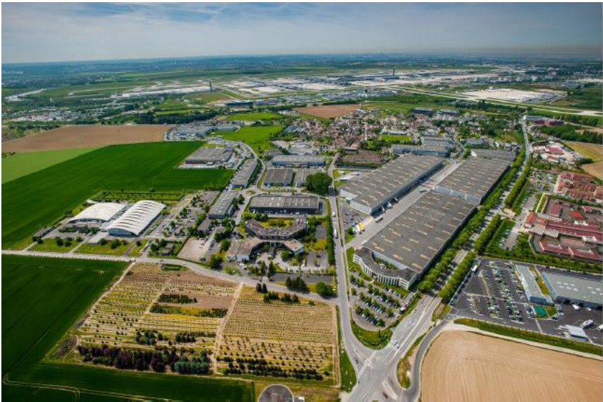
Figure 45 : Vue sur Le Mesnil-Amelot depuis le nord (Source : commune du Mesnil-Amelot-2017)
